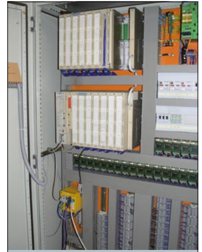
Implementacja Echolinka w szafie sterowniczej, jako integracja sterownika S5 z systemem MES
